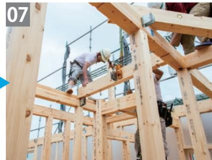
07 金物による柱と梁の施工
