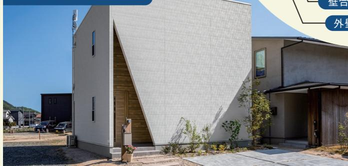
外壁工事における現場の職人不足の課題を、プレカットによって解消します。建物サイズを採寸して専用CADに入力、全自動加工機でプレカットするため、あとは現場で貼るだけで、大幅な工期短縮と廃材削減が可能です。
