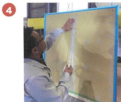
ビス穴、V溝のパテ後、しっかり乾燥させてからジョイントテープを貼ります。
